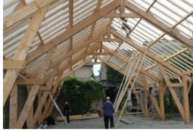
Montage des baches sur la structure du hangar
