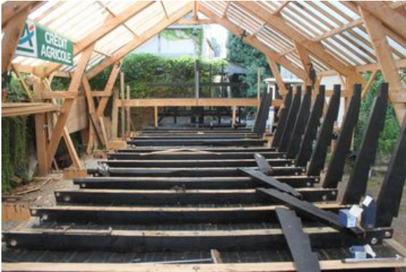
Septembre 2014: une nouvelle étape, la pose des membrures. Le gabarot prend forme!
