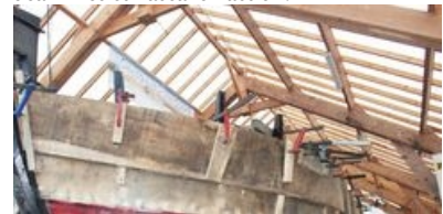
Fin 2015, pose de la quatrième planche de bordé.
