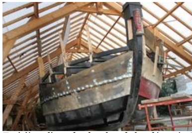
Troisième ligne de planches de bordé posées! avec un aperçu de la couleur lie de vin qui sera appliqué sur les trois dernières planches de bordé.
