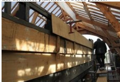
27 février 2016: pose de planches droites
