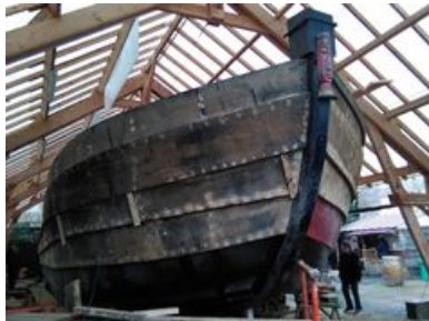
Les dernières planches de bordé posées.
